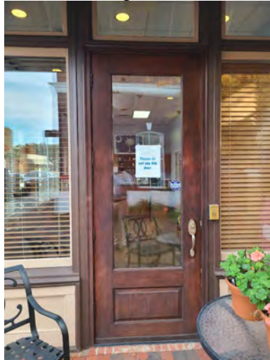
Existing Side Door (side front)
