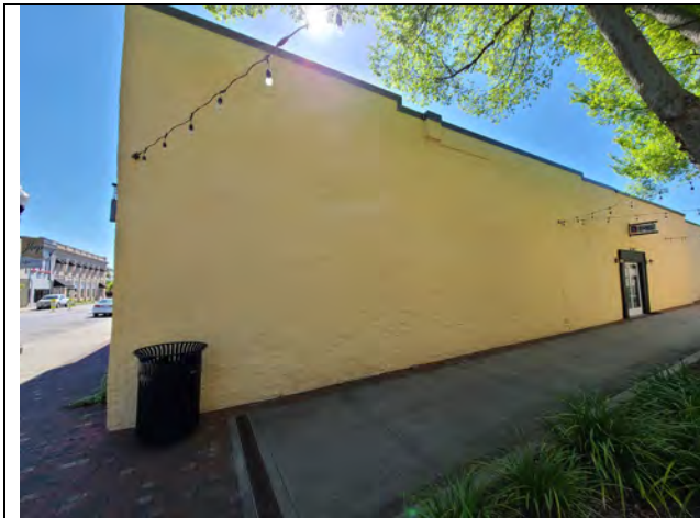
16 W. Liberty St. (Berenyi/F45/Liberty Center west-facing wall)
